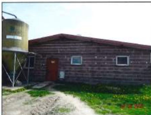
Budynek chlewni (porodówka)
